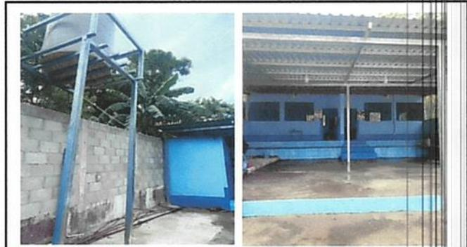
Foto 4: Instalacion de estructura metalica y deposito de agua con sus accesorios, asi mismo la galera en el patio con su respectiva estructura metalica y lamina troquelada.
